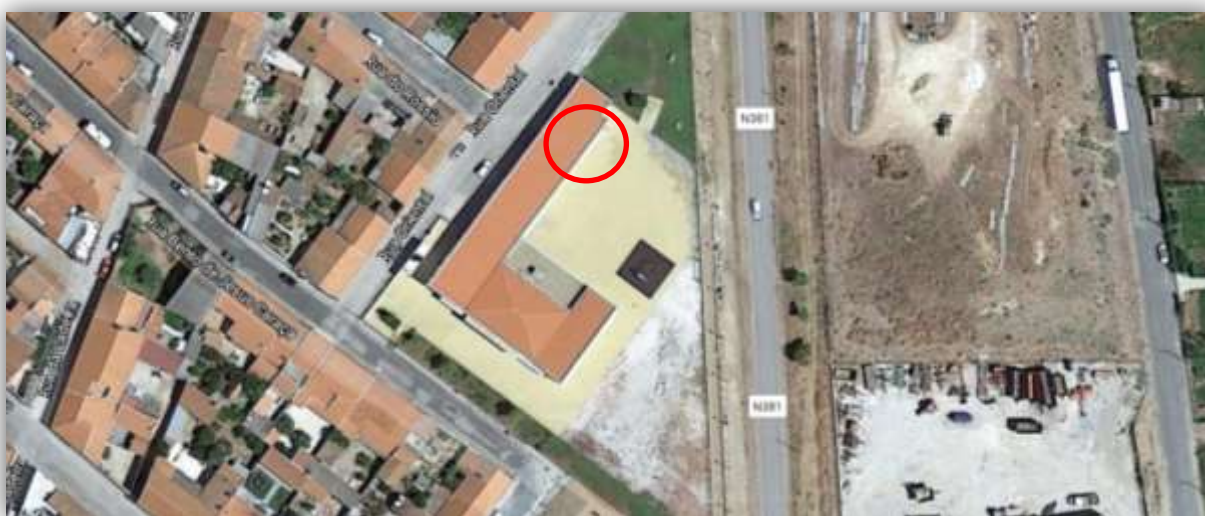
Fig. 2 – Sala de Isolamento EB de Montoito
